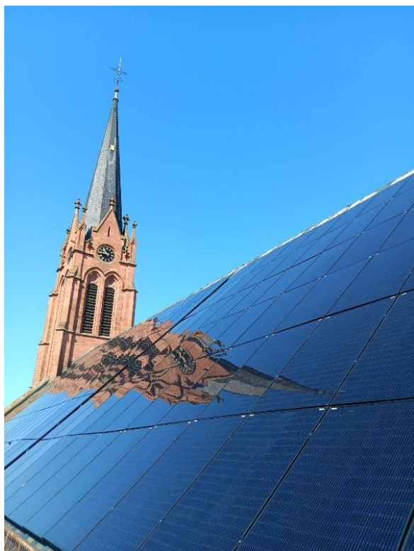
Installation de 67,2 kWc (ou 168 panneaux) sur l'Église de Steinbourg
